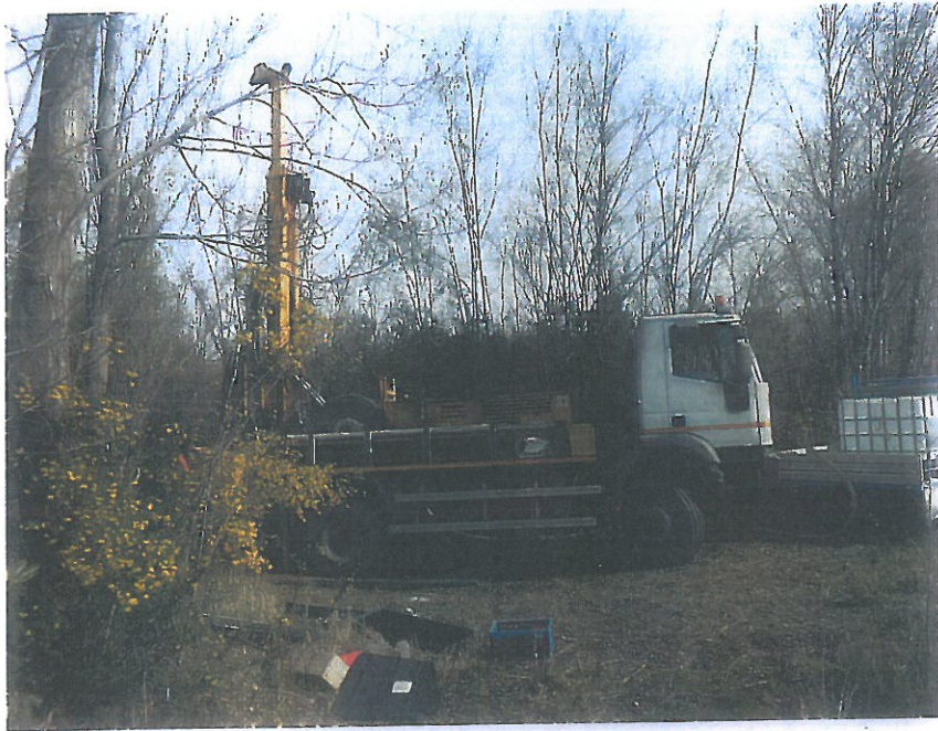
Sondaggio P1: posizionamento delle attrezzature.
