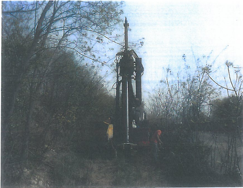
Sondaggio P2: posizionamento delle attrezzature.
