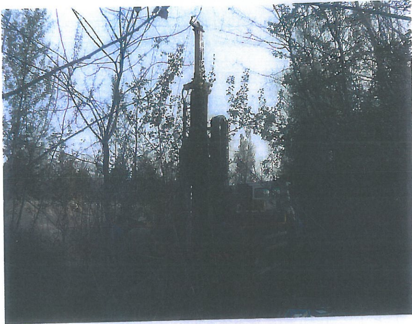
Sondaggio P4: posizionamento delle attrezzature.
